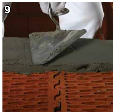
8 9 Под перекрытия необходимо уложить постель из цементно-песчаного раствора
