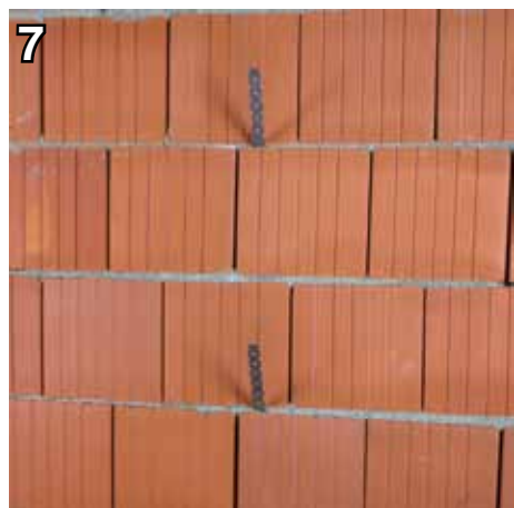
7 Количество анкеров соединяющих внутренние перегородки с несущими стенами определяется по расчету. Анкеры устанавливаются через каждые 2 ряда блоков
