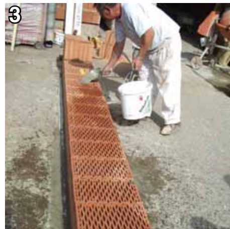
3 Перед укладкой блоки необходимо смачивать водой
