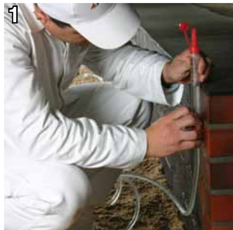
1 Установка горизонтальной гидрозащиты
