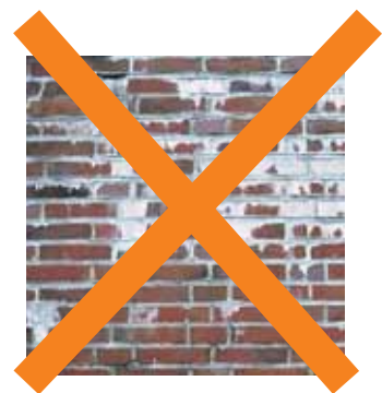
Полное прочное сцепление раствора марки V.O.R. фирмы «quick-mix» предотвращает «блуждание» воды внутри каменной кладки, которое ведет к так называемым выщелачиваниям или к появлению налета извести
