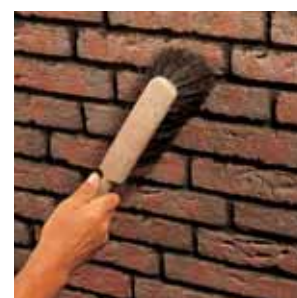
4. Прочное, без трещин сцепление кирпича с основанием, однородная герметичная структура шва, водонепроницаемая, морозостойкая и погодоустойчивая кладка.
