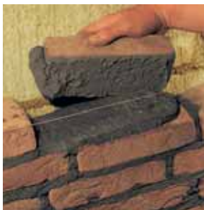
По основанию приподнятого кирпича видно, что достигается сплошное сцепление раствора с основанием камня и сплошное заполнение шва раствором по всей поверхности.
