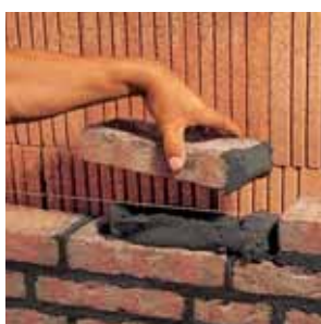
1. Укладка камня на высокопластичном кладочном растворе V.O.R. с полной заливкой швов, выпускаемом фирмой «quick-mix». Прочное сцепление раствора с кирпичом.
