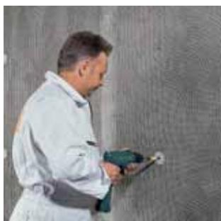
Затем через армирующую сетку PUG плиты крепят тарельчатыми дюбелями LOBATHERM и головки дюбелей шпаклюют RAS способом «мокре по мокрому». Минимальная общая толщина армирующей слоя составляет 7 мм.
