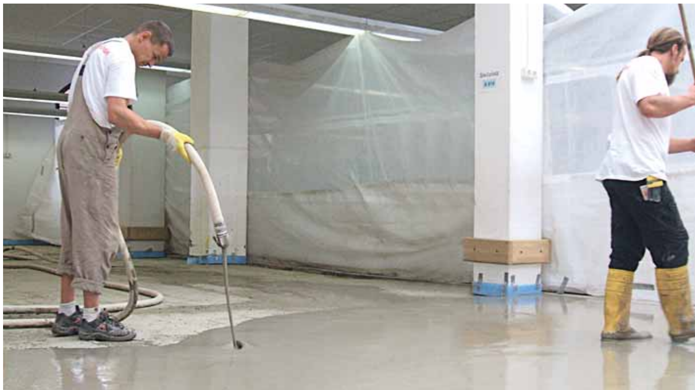
Главный почтамт в Галле / Рациональное машинное нанесение ремонтной стяжки RE 50
