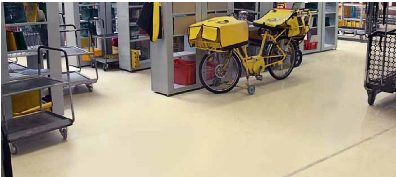
Главный почтамт в Галле / Ремонтная стяжка RE 50 с эпоксидным покрытием.
